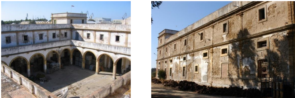
Figura 3. a) Patio Antiguo y b) Fachada lateral, apreciación entreplanta.
