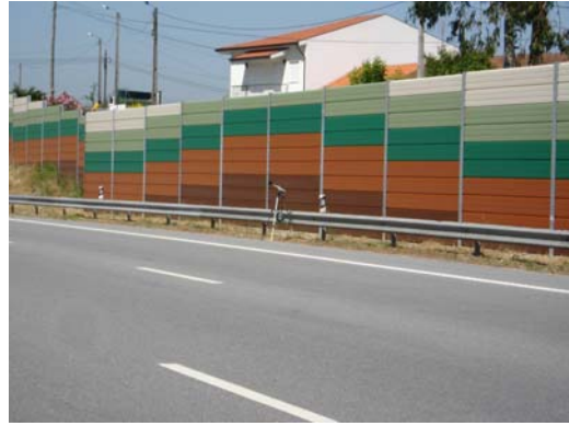
Figura 5: Caso de estudo 2 – aspecto da barreira acústica.
