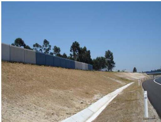
Figura 6: Caso de estudo 3 – aspecto da barreira acústica.
