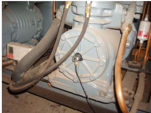
Figura 3 – Colocación del acelerómetro triaxial en el punto de medida 1.
