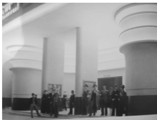
Figura 02 – Vista noturna da entrada
