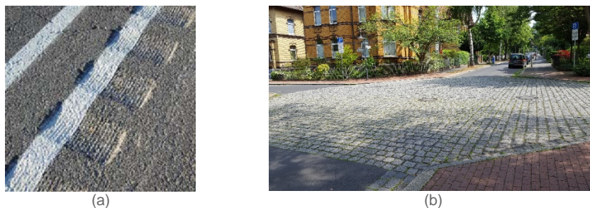
Figura 2. Configuraciones de pavimento empleadas por razones de seguridad. (a) macrotextura negativa en carretera secundaria para delimitación de arcen. (b) superficie adoquinada en cruce de calles.
