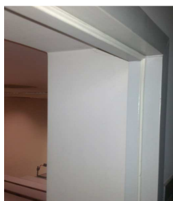
Figura 3 - Colmatação da frincha lateral e superior das duas portas da sala B024.
