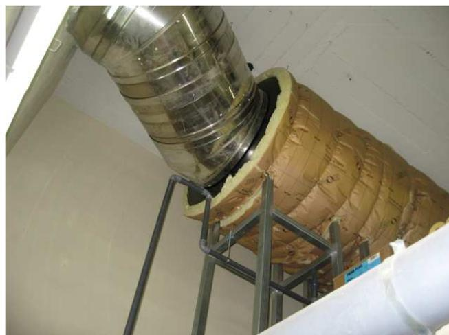
Figura 8 – Filtro acústico instalado en el tubo de escape de la caldera 3.
