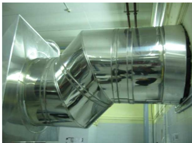
Figura 2 – Tubo de salida de gases de una de las calderas
