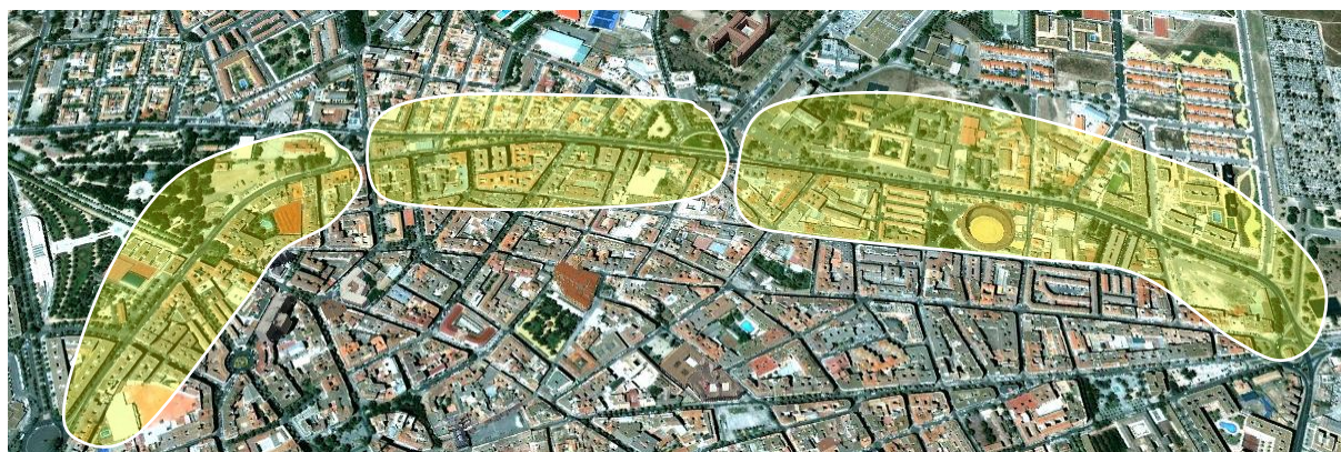
Figura 4 – Tramificación de la zona de estudio sobre vista aérea de la ronda oeste de Ciudad Real.
