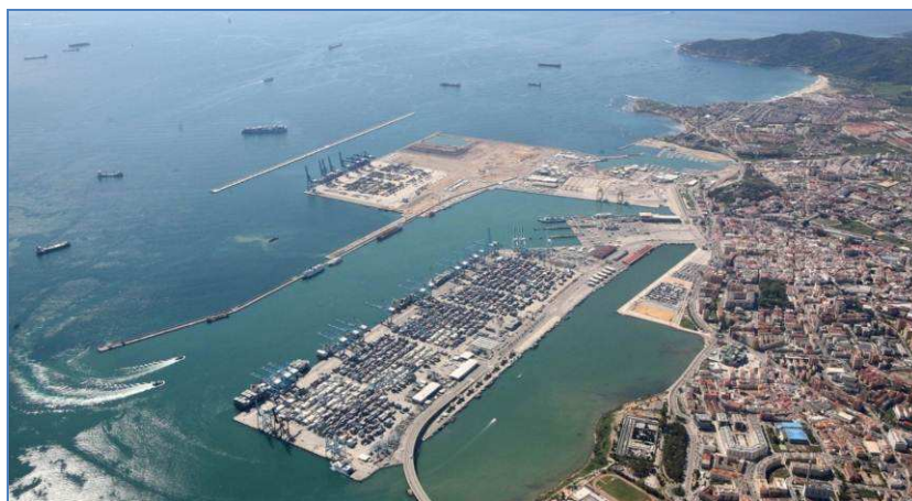
Figura 1 - Vista general del puerto de Algeciras
