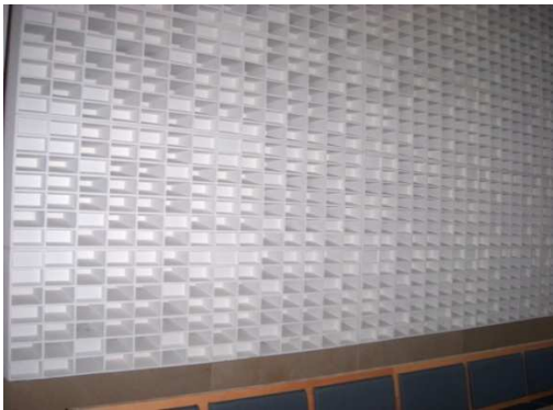
Figuras 7 e 8 – Difusores acústicos da parede de retaguarda da assembleia (à esq.) e parede revestida com Akustaplan (parte branca da parede da foto à dir.)
