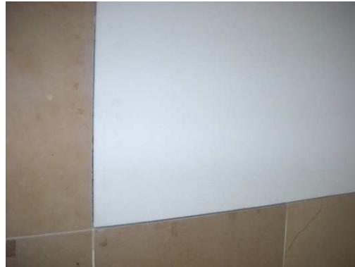
Figuras 7 e 8 – Difusores acústicos da parede de retaguarda da assembleia (à esq.) e parede revestida com Akustaplan (parte branca da parede da foto à dir.)
