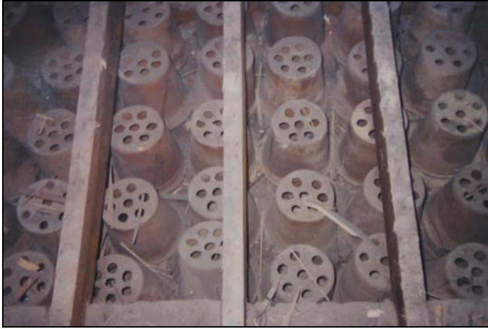
Figuras 6 y 7 - Teatro Principal de Valencia. Cámara subterránea bajo el foso orquestal y vasija cerámica. 1989 (Archivo del Departamento de Arquitectura de la Diputación Provincial de Valencia)
