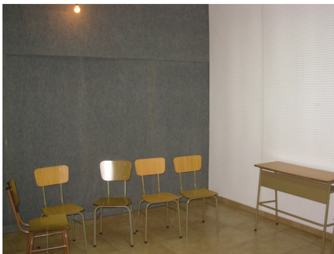
Fig. 8. Detalle de una de las aulas (Multimedia) del Instituto Superior de Música, refuncionalizada para dividirse en dos sectores o funcionar como sala única, tratada acústicamente y térmicamente (en construcción). (Castellón, Pablo Daniel et al., 2008)
