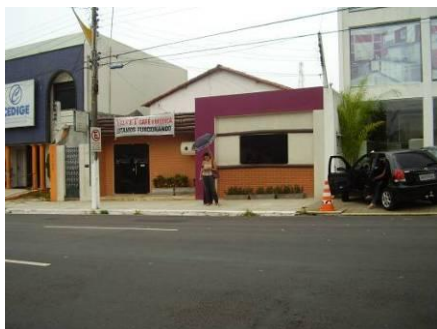
Figura 7. Foto da medição na calçada “x” – ponto 1
